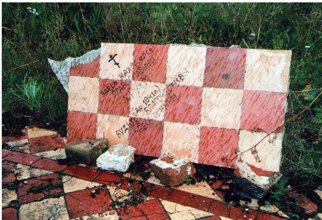
Илл. 54. Фундамент церкви Смоленской иконы Божией Матери. Фото 28.08.2009.
