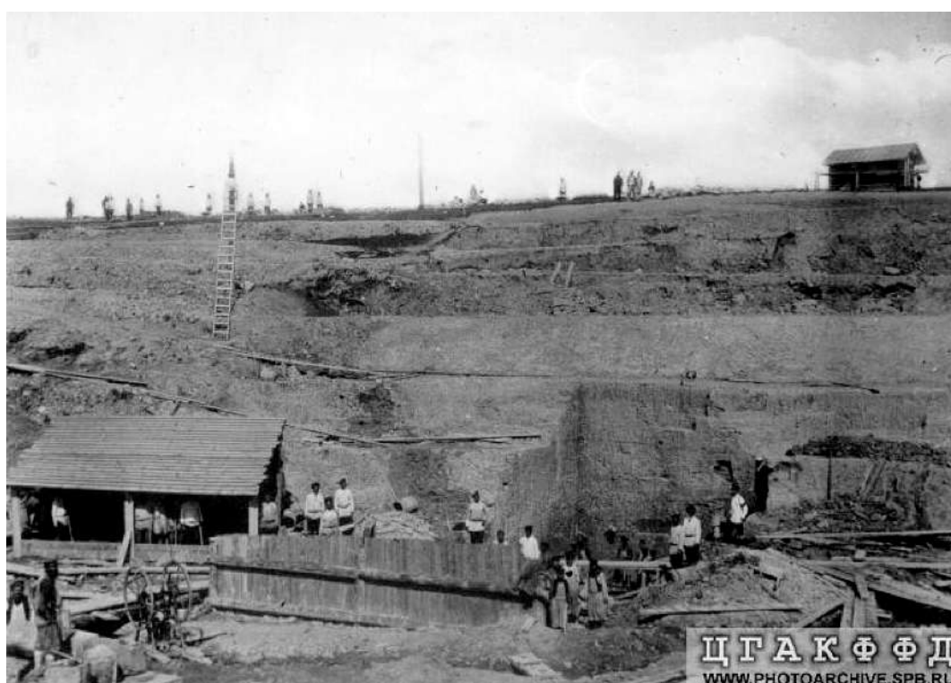
Илл. 31. Строительство котлована для моста через Кузьминку 1895. ЦГА КФФД
