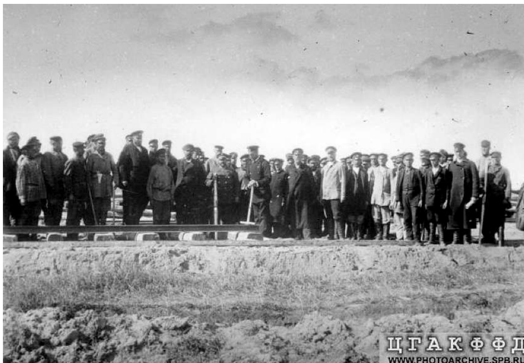
Илл. 34. Строители перед началом укладки пути на насыпь 1895-1898. ЦГА КФФД
