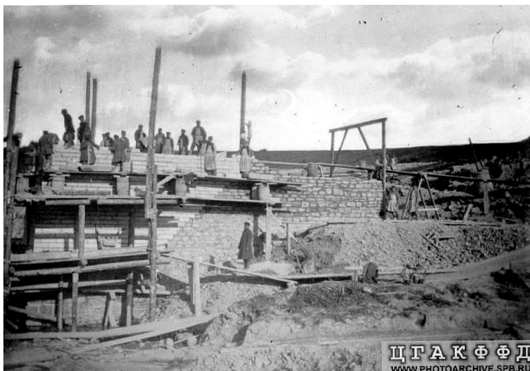
Илл. 30. Строительство моста через р.Кузьминку Возведение западной (Варшавской) опоры моста. 1895 г. (август)
