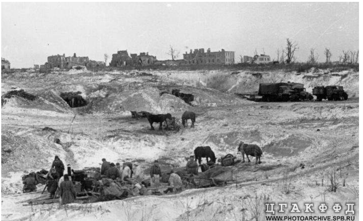
Илл. 48. Вид на разрушенные здания Пулковской обсерватории. 1942 год.
